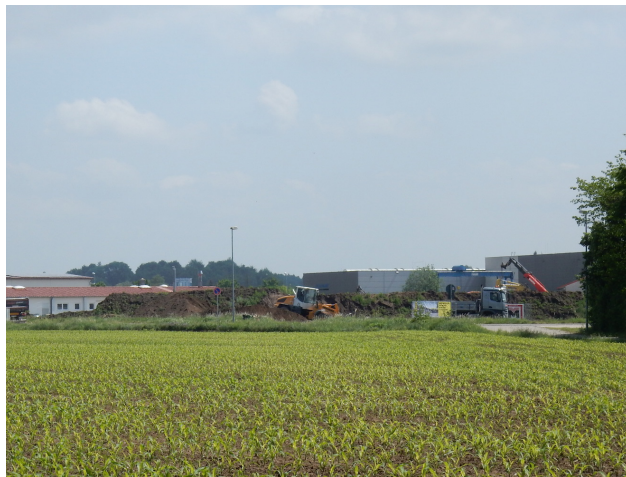
Blick in südlicher Richtung (auf Höhe der B 466)
