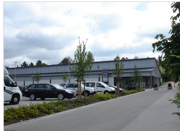
Blick auf Aldi-Immobilie in südöstlicher Richtung
